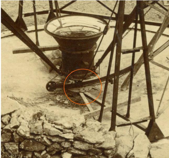
Le support en X est difficile à comprendre. On sait qu'il n'est peut-être pas horizontal et que le centre peut être plus bas que le dessus du rail de rotation. Il comporte au centre une plaque ronde de diamètre à peine inférieur à la base du cylindre du récepteur. Mais une photo donne une interprétation différente et suggère qu'un des bras du X est aligné alors que l'autre le rejoint avant le centre. L'interprétation reste entière.
